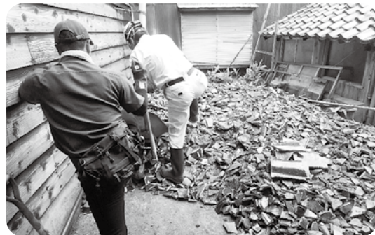
山形県沖地震での瓦の撤去作業
